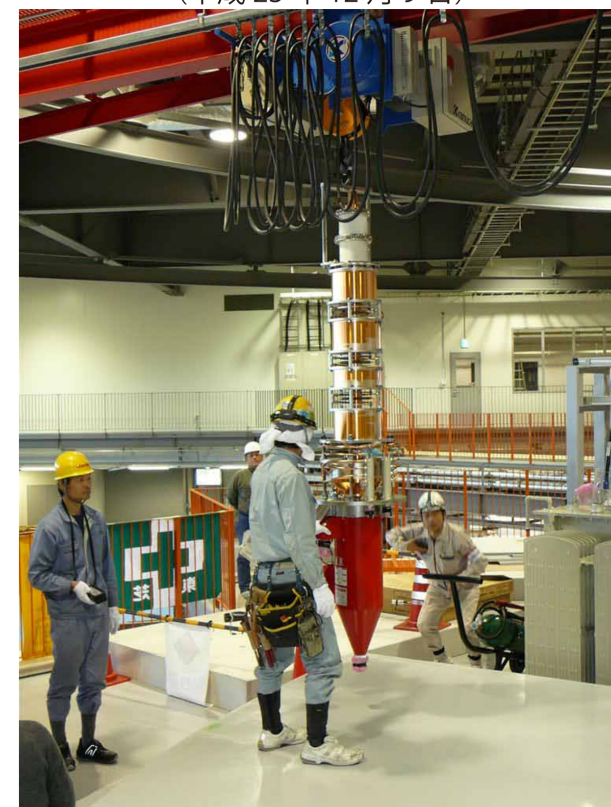
蓄積リング用クライストロン設置作業 (平成 23 年 12 月 9 日)
