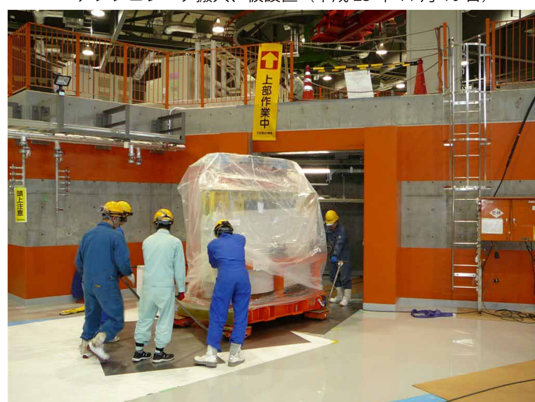
アンジュレータ搬入、仮設置 (平成 23 年 11 月 10 日)
